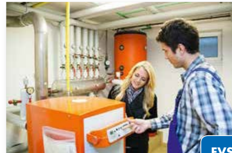
Mitte Die Elektrokesselanlage ist ein flexibler Baustein im Anlagenportfolio der EVSE
