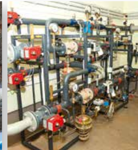
Links Bauarbeiten an einer Fernwärmeleitung Mitte Die Hausanschlussstation im Keller des Schweriner Schlosses Rechts Verlegung der Versorgungsleitungen vom Alten Garten zum Schweriner Schloss
