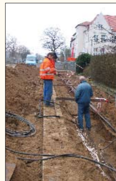
In der Graf-Schack-Allee werden durch die EVS und im Auftrag der Netzgesellschaft die Versorgungsleitungen erneuert Foto: SWS
