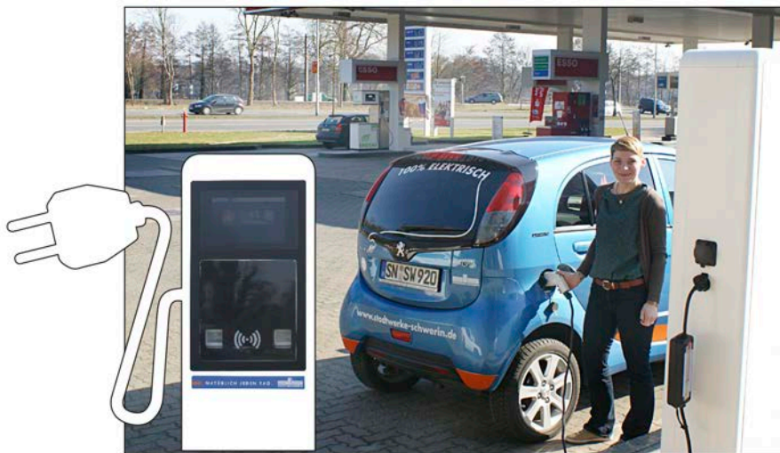
BU: Stadtwerke-Mitarbeiterin Juliane Deichmann lädt das E-Auto der Stadtwerke an der neuen Ladesäule am Püsserkrug.
